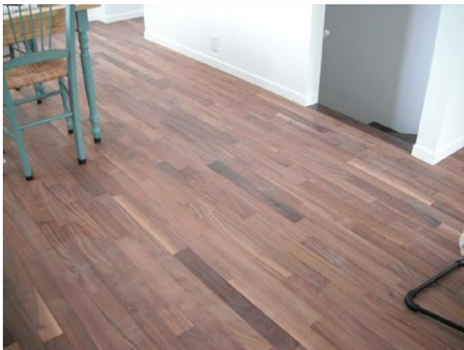
施工後のそのまま状態
